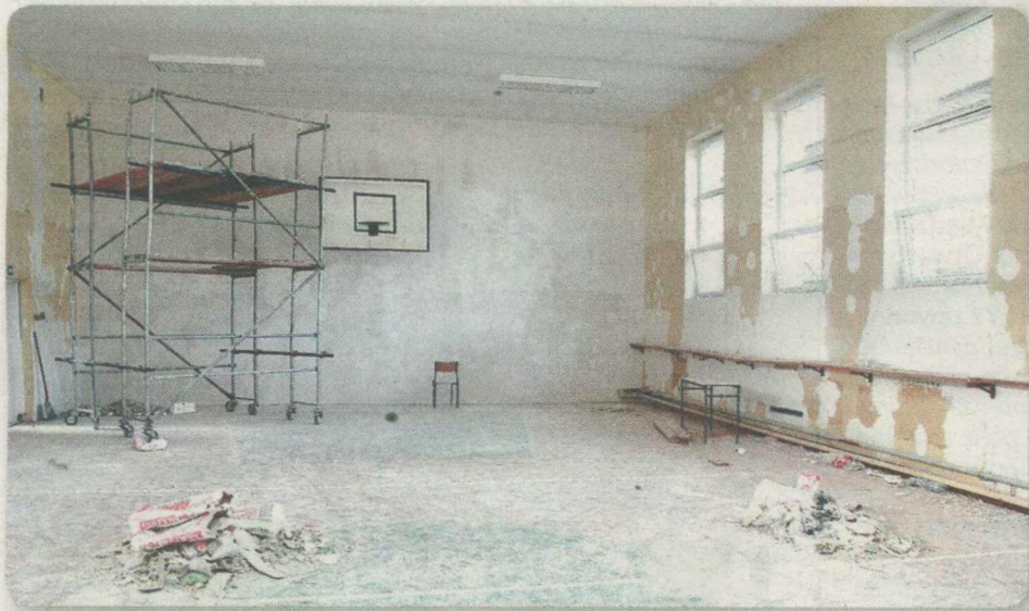
Już za miesiąc uczniowie LO będą mogli korzystać ze zmodernizowanej małej sali gimnastycznej.
