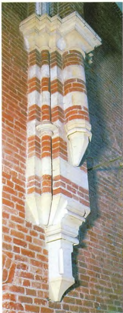
Kamienno-ceglany wspornik sklepień prezbiterium.
