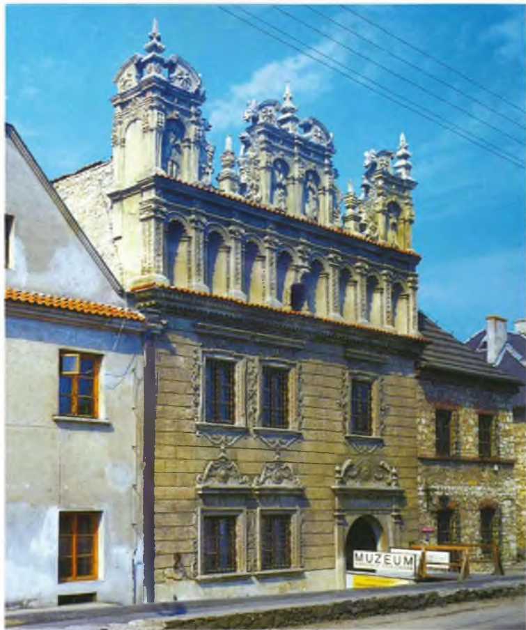
Fasada kamienicy Celejowskiej przy ul. Senatorskiej.
