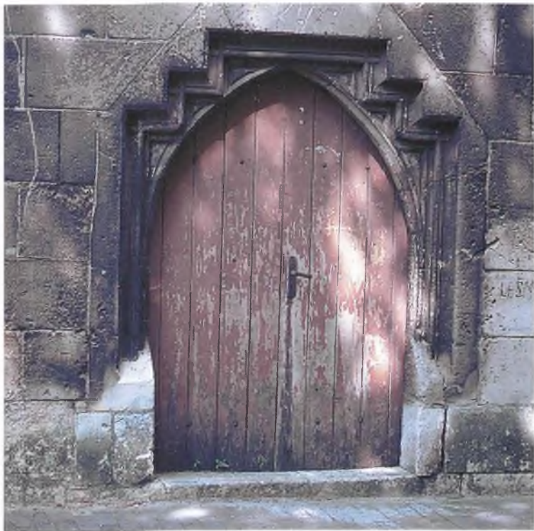
Południowy portal dzwonnicy.
