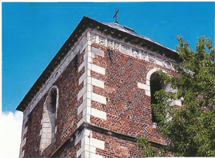
Widok górnej części dzwonnicy z fryzem heraldycznym.
