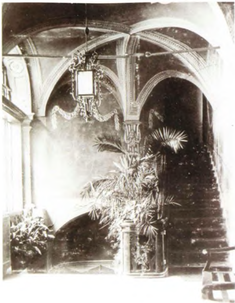
Klatka schodowa wg fotografii z ok. 1930 roku.
