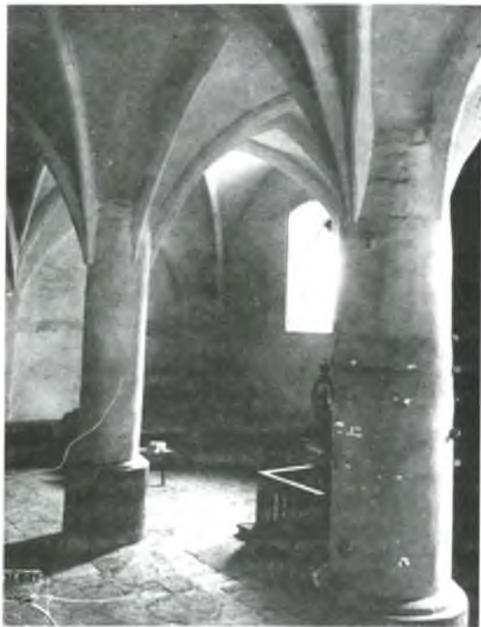
Wnętrze zniszczonego kapitularza wg fot. Kazimierza Broniewskiego z XIX/XX wieku.
