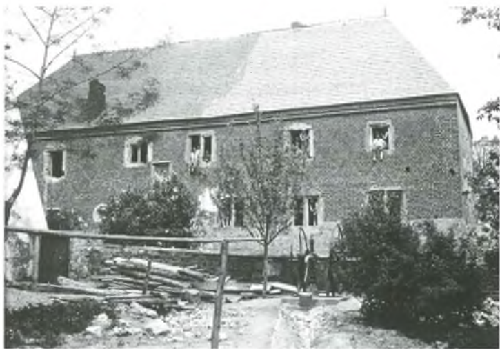
Dom Długosza w trakcie remontu w pocz. XX wieku
