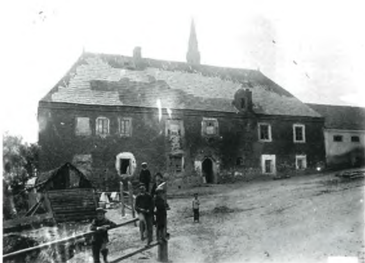
Elewacja północna Domu Długosza na fotografii Komerowskiego z 1917 roku.
