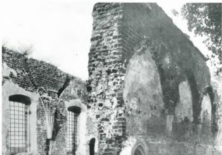
Zniszczone skrzydło północne wg fotografii z 1926 roku.
