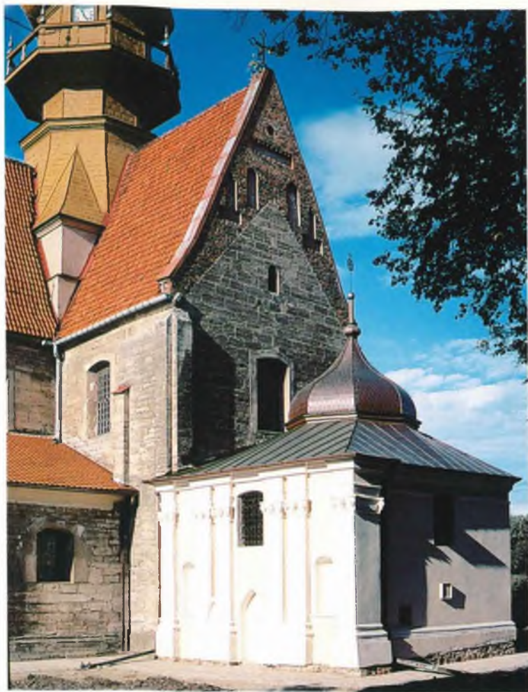
Południowe ramię transeptu z kaplicą św. Walentego.
