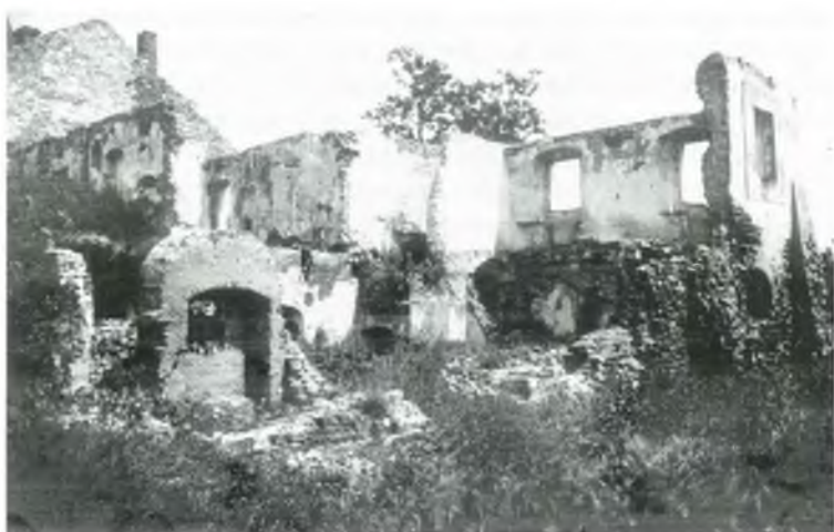
Zrujnowana południowa część wschodniego skrzydła klasztornego wg fotografii z pocz. XX wieku.
