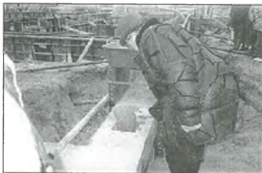
Wmurowanie aktu erekcyjnego przez dyr. H. Tworka – 1996 r.
