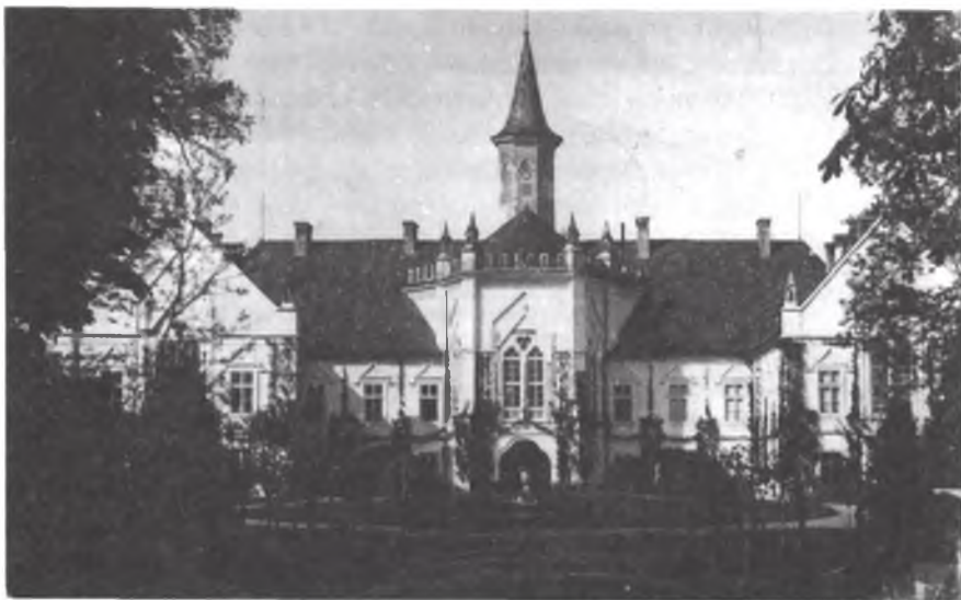
Pałac w Dzikowie przed przebudową i zmianą dziedzica - początek XX wieku
